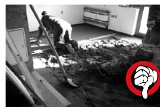
Tradiční potěr - pracné a pomalé provádění
