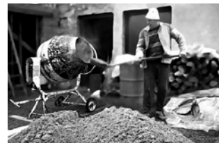
Výroba na staveništi
