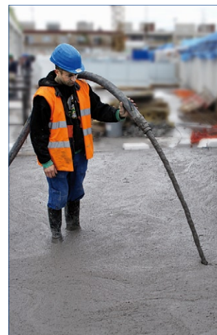
POROFLOW® FS lité směs na bázi cementu, technické pěny a polystyrenového granulátu
