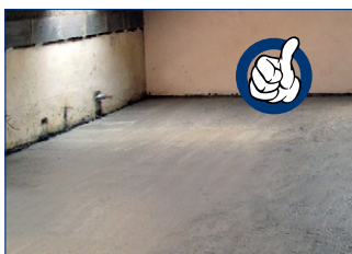
Poroflow - optimální rovina povrchu
