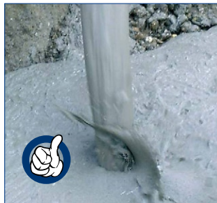
Poroflow - samovolné vyplnění bez nutnosti hutnění
