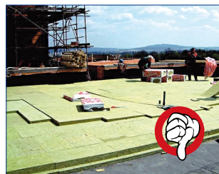
Složitě provádění spádů
