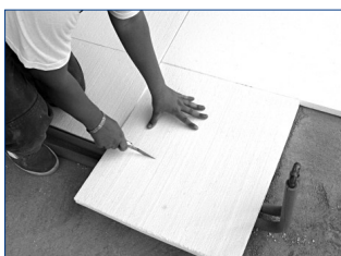
Složitý a pomalý způsob pokládky deskových izolačních materiálů
