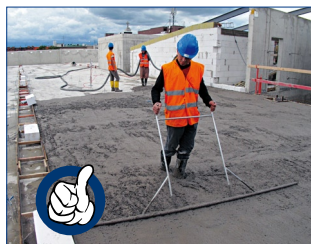
Poroflow - snadné provádění spádů
