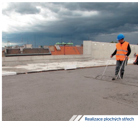
Realizace plochých střešů
