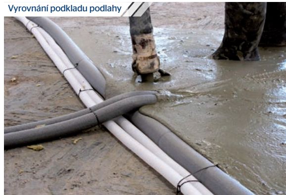
Vyrovnání podkladu podlahy
