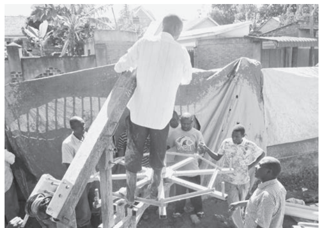
Mitarbeiter beim Bau des Brunnens
